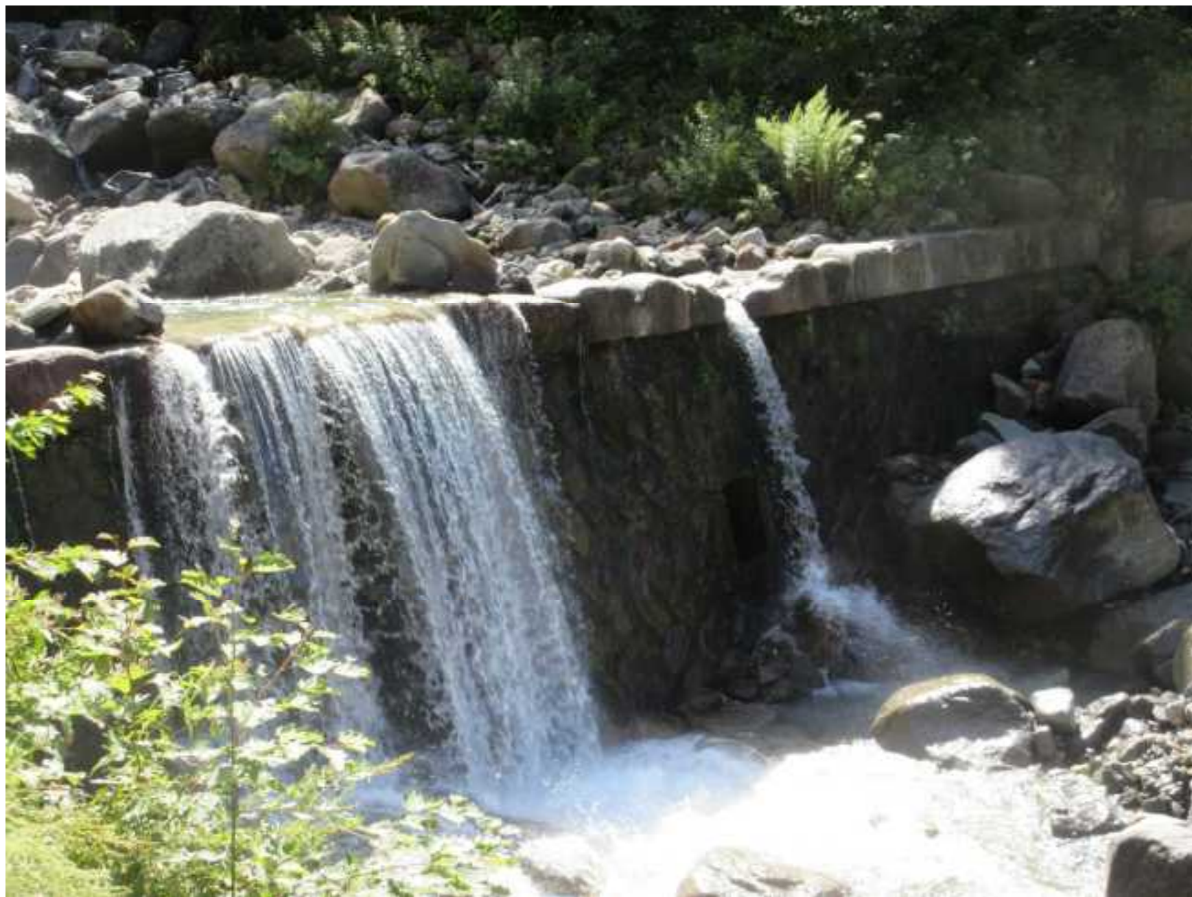
柳谷第7号堰堤 R1.9撮影
