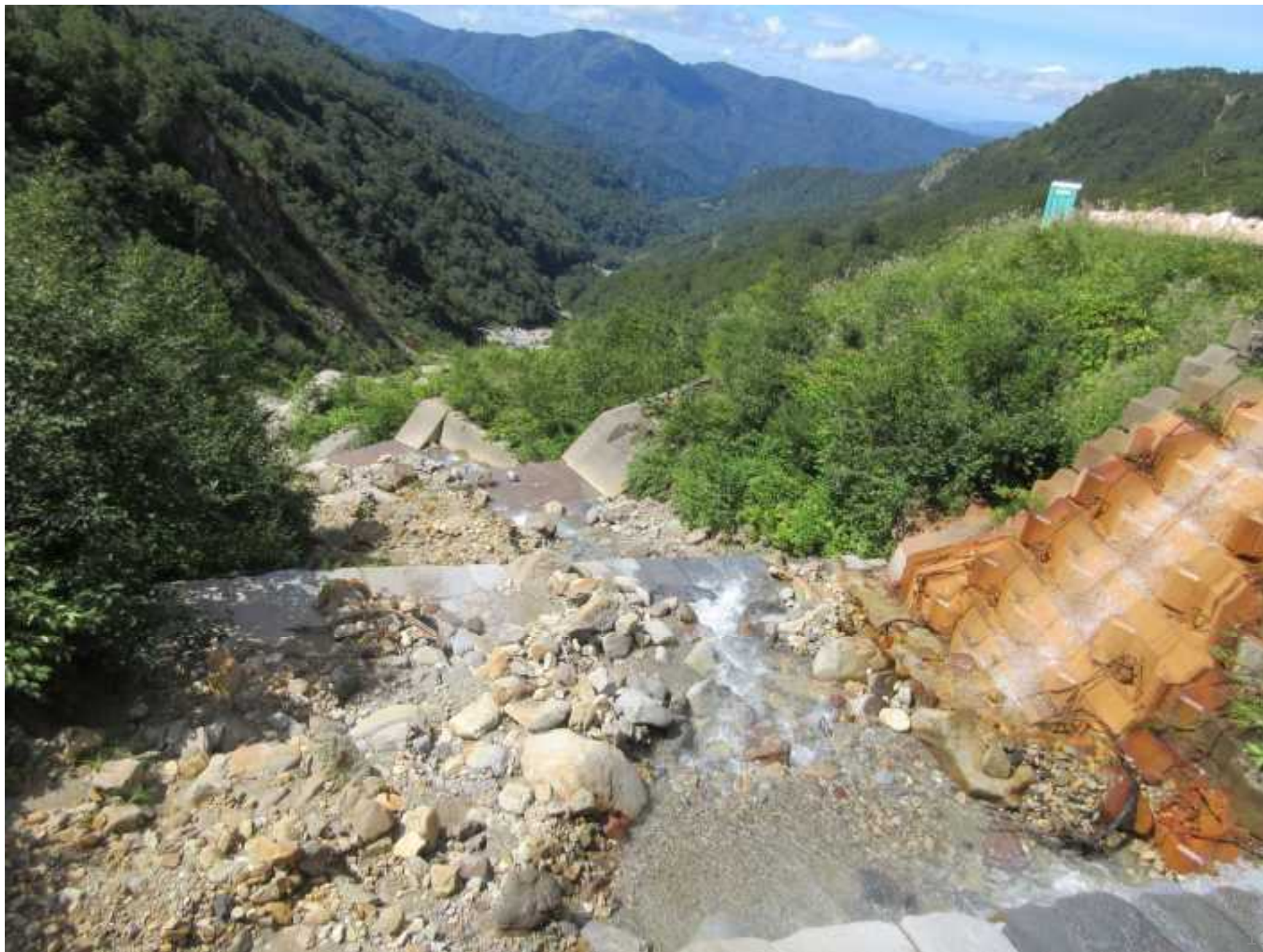
甚之助第7号堰堤 埋没付近 R1.9撮影
