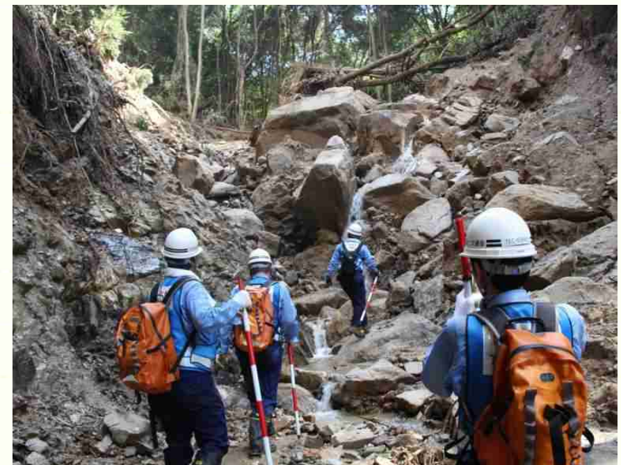
TEC-FORCEによる溪流内不安定土砂の 堆積状況等二次災害防止のための現地調査
