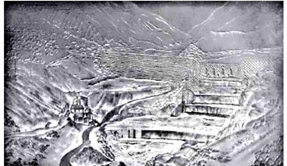
足尾砂防堰堤(栃木県)
