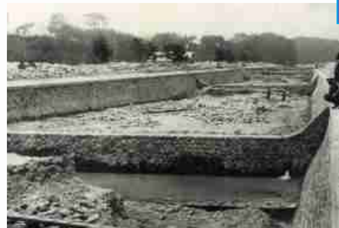
流路工施工後(昭和初期)
